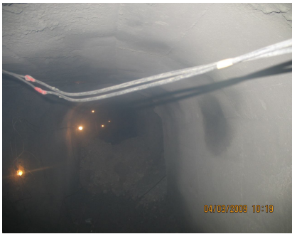
图 3 光面爆破巷道形状 Fig.3 Tunnel shape on smooth blasting
